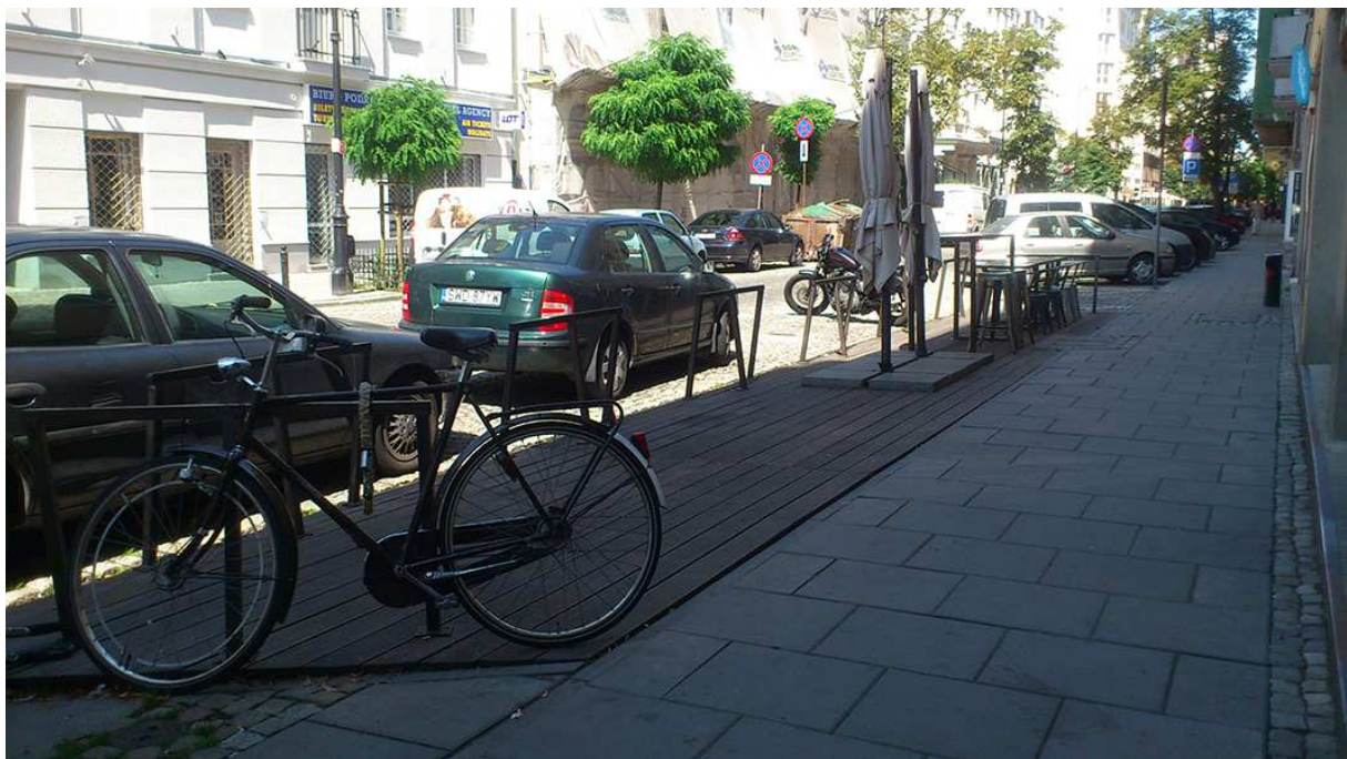
Fot. 12. Podest z wygradzeniem dla ogródka letniego na miejscach parkingowych poza obszarem objętym strefą zamieszkania – przykład z Warszawy.
