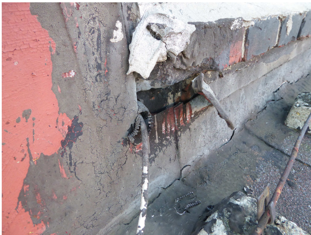
Rys. 15, 16. Strefy opierzeń kominów
