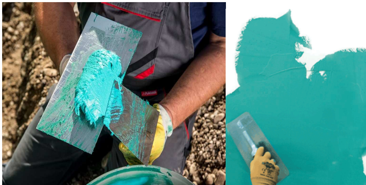
Rys. 1. Przygotowanie materiału i wykonanie szpachli drapanej
