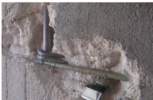
Rys. 9. Przykład antykorozyjnie zabezpieczania prętów zbrojeniowych
