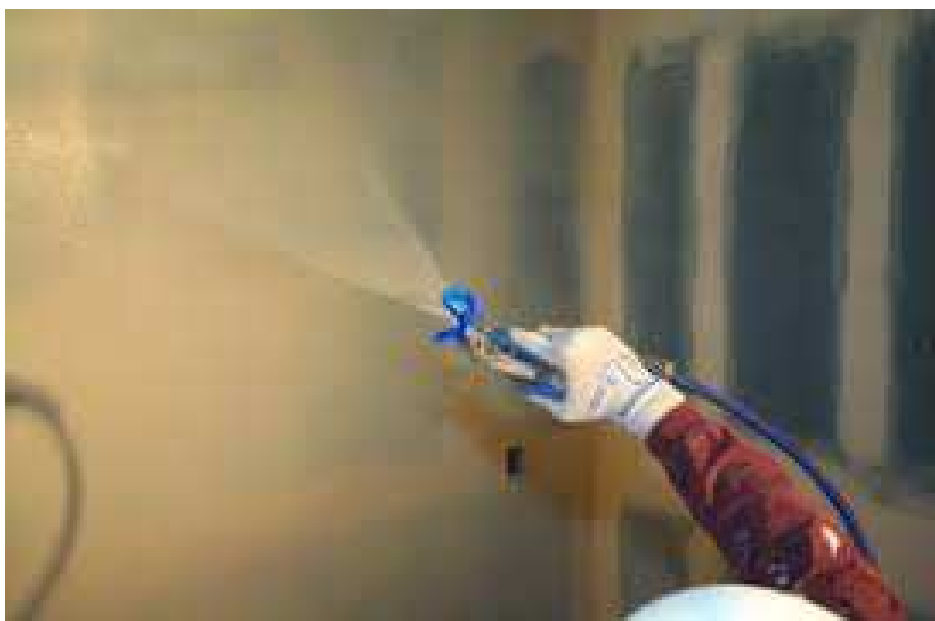
Rys. 13. Przykład nakładania warstwy paroizolacji w postaci powłoki malarskiej przy pomocy natrysku
