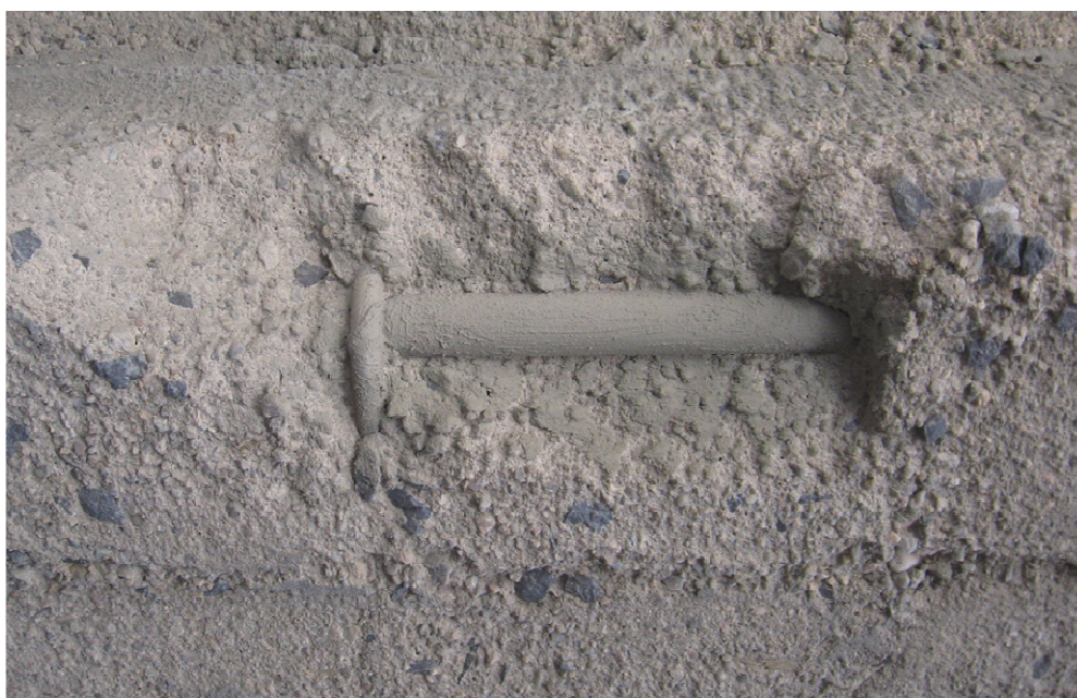
Rys. 10. Przykład warstwy szepnej na przecie zbrojeniowym
