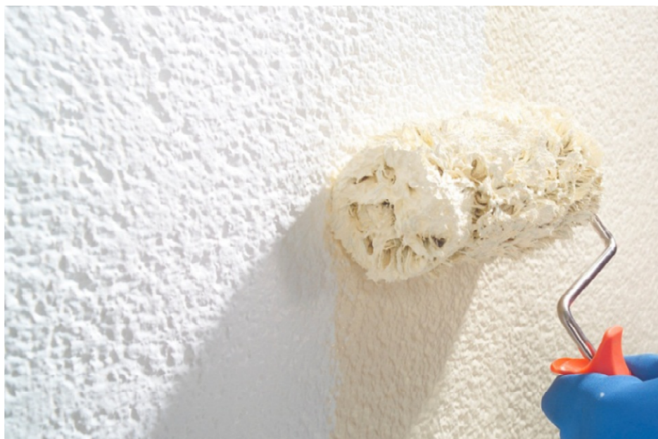
Rys. 12. Przykład nakładania warstwy paroizolacji w postaci powłoki malarskiej przy pomocy wałka
