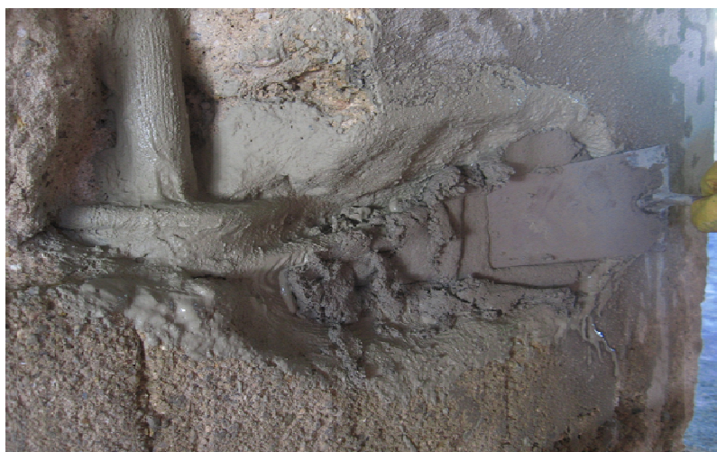
Rys. 11. Przykład nakładania warstwy naprawczej w postaci wysokiej jakości zaprawy polimerowo-cementowej
