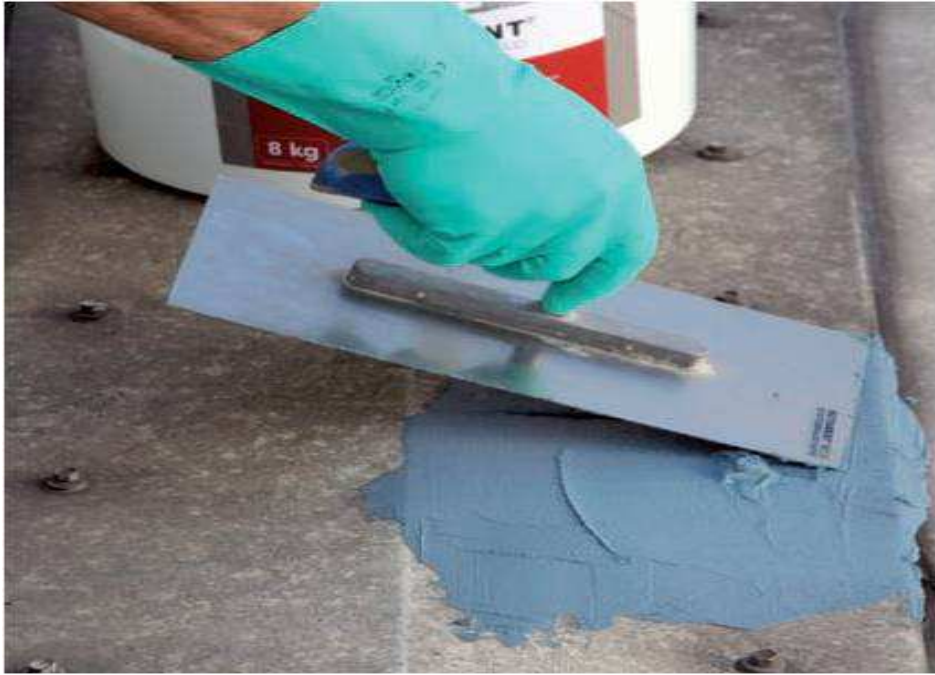
Rys. 2. Nakładanie techniką ręczną przy pomocy pacy stalowej gładkiej z wygładzeniem przy pomocy pędzla
