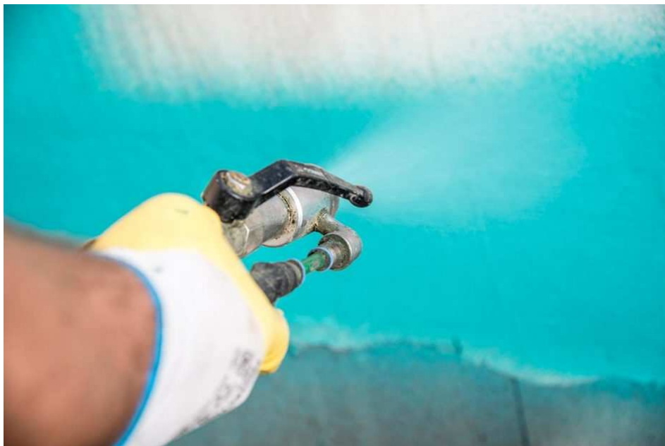
Rys. 3. Nakładanie natryskiem bezpowietrznym
