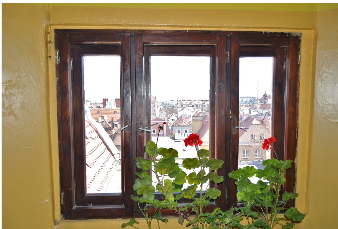
Il. 22 Poznań, ul. Masztalarska 8 – Klatka schodowa „C” (północno-zachodnia) - V kondygnacja klatki schodowej – okno nr 5 (rewers)
