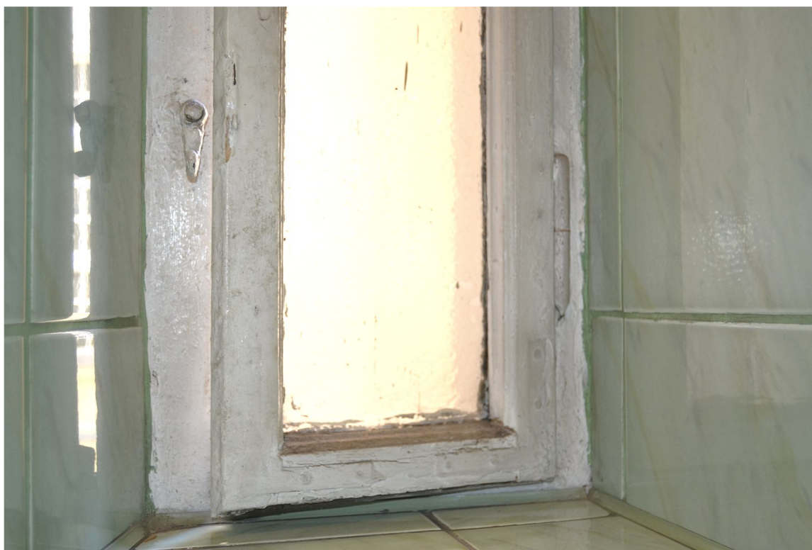
Il. 34 Poznań, ul. Masztalarska 8 – Sanitariaty przy klatce schodowej „C” (północno-zachodniej) - widok na fragment stolarki okiennej (próg skrzynki, stojak oraz skrzydło okienne i parapety)
