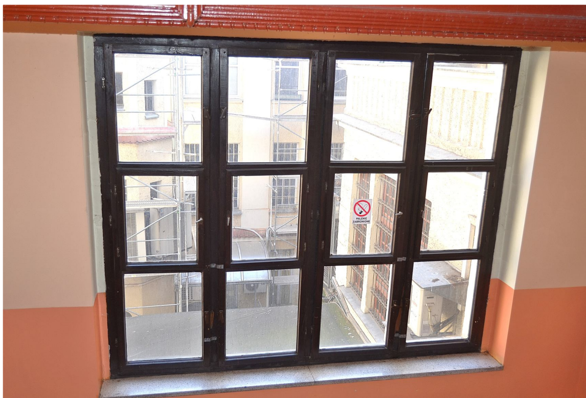
Il. 12 Poznań, ul. Masztalarska 8 – Klatka schodowa „B” (południowo-zachodnia) - II kondygnacja klatki schodowej – okno nr 2 (rewers)
