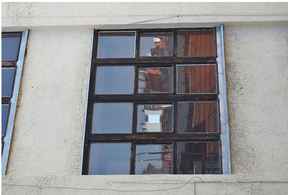
Il. 11 Poznań, ul. Masztalarska 8 – Klatka schodowa „B” (południowo-zachodnia) - I kondygnacja klatki schodowej – okno nr 2 (awers)
