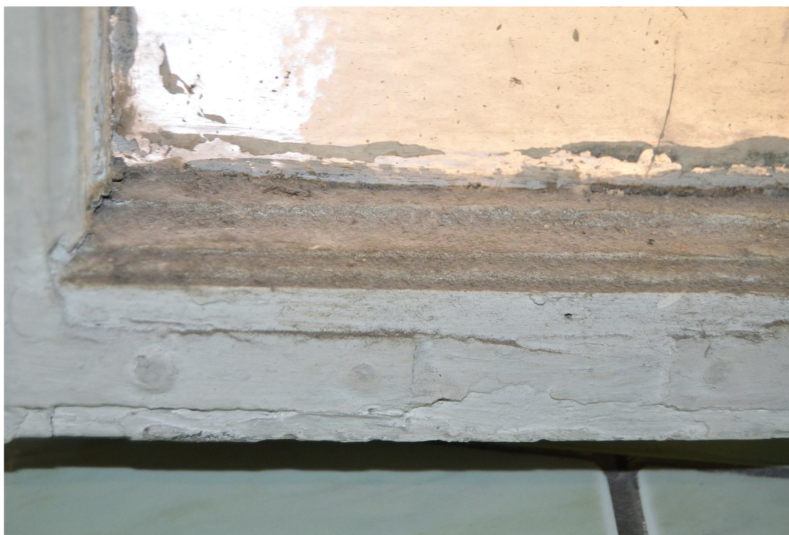
Il. 36 Poznań, ul. Masztalarska 8 – Sanitariaty przy klatce schodowej „C” (północno-zachodniej) - widok na fragment stolarki okiennej (próg skrzynki, stojak oraz skrzydło okienne i parapety)
