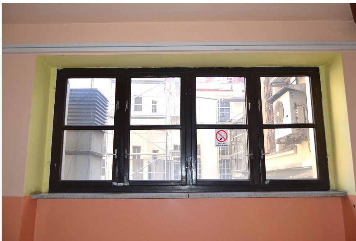
Il. 10 Poznań, ul. Masztalarska 8 – Klatka schodowa „B” (południowo-zachodnia) - I kondygnacja klatki schodowej – okno nr 1 (rewers)
