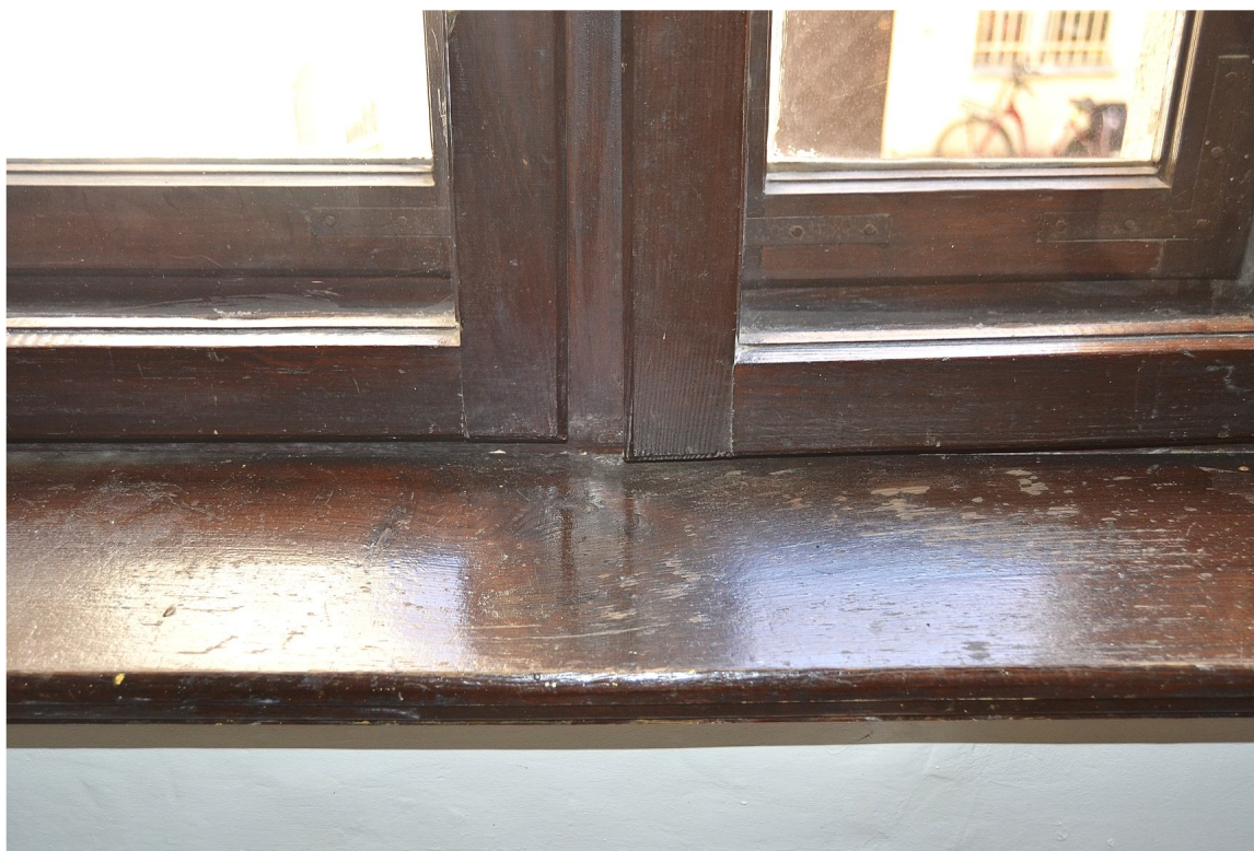
II. 24 Poznań, ul. Masztalarska 8 – Klatka schodowa „C” (północno-zachodnia) - widok na fragment skrzydeł okiennych oraz parapet wewnętrzny
