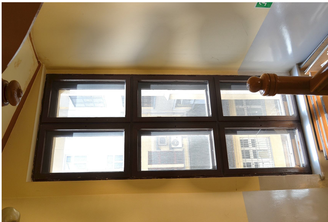
II. 27 Poznań, ul. Masztalarska 8 – Klatka schodowa „D” (północna) - II kondygnacja klatki schodowej – okno nr 2 (rewers)
