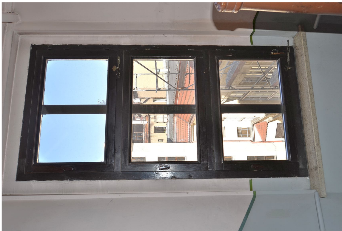
II. 5 Poznań, ul. Masztalarska 8 – Klatka schodowa „A” (południowa) - IV kondygnacja klatki schodowej– okno nr 4
