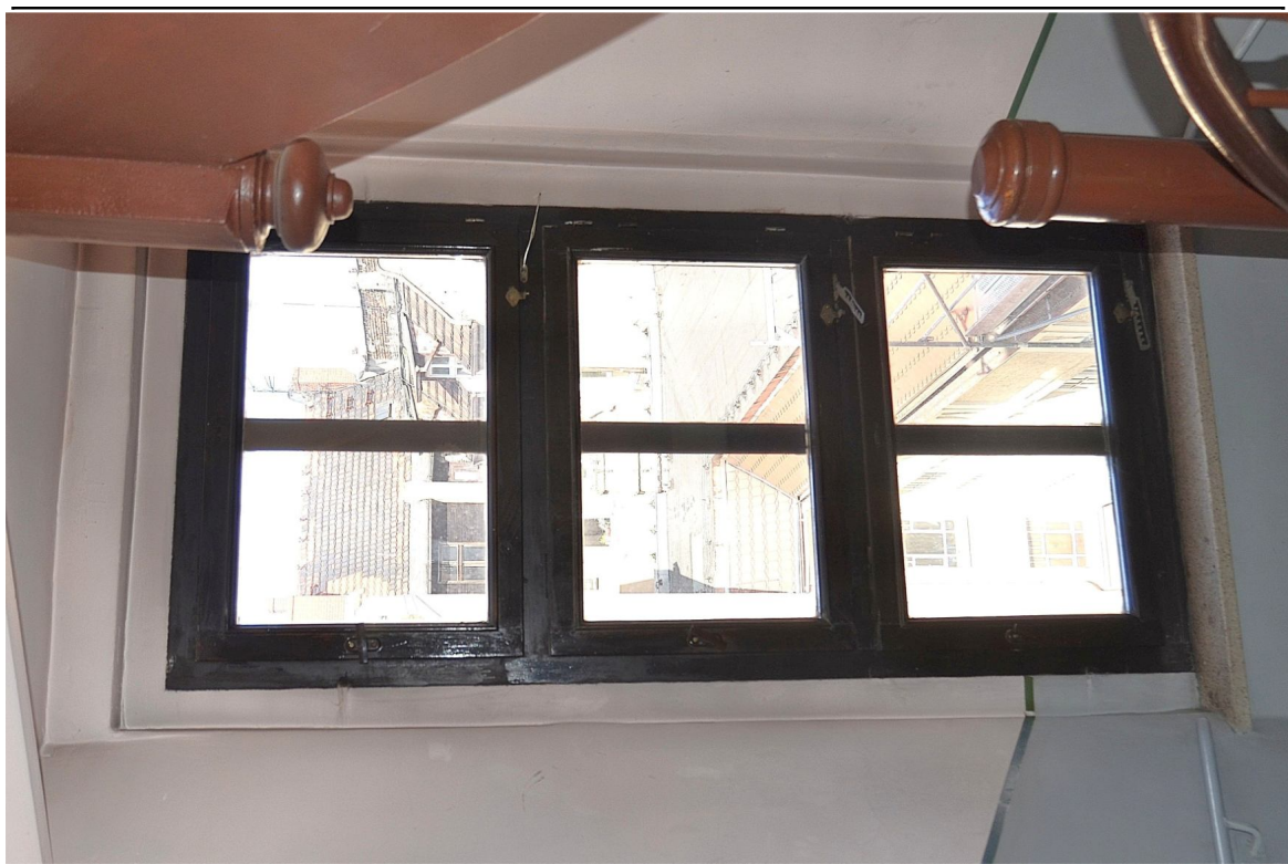
II. 4 Poznań, ul. Masztalarska 8 – Klatka schodowa „A” (południowa) - III kondygnacja klatki schodowej– okno nr 3
