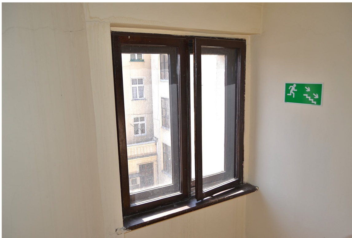
Il. 29 Poznań, ul. Masztalarska 8 – Klatka schodowa „D” (północna) - IV kondygnacja klatki schodowej – okno nr 4 (rewers)
