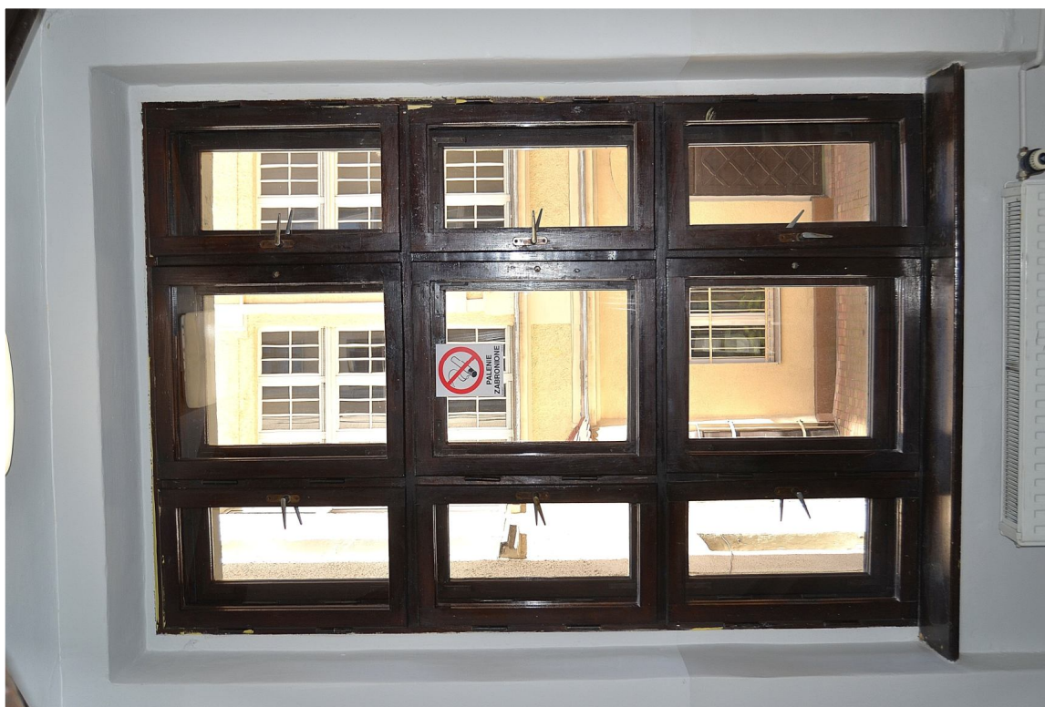
II. 18 Poznań, ul. Masztalarska 8 – Klatka schodowa „C” (północno-zachodnia) - I kondygnacja klatki schodowej – okno nr 1 (rewers)
