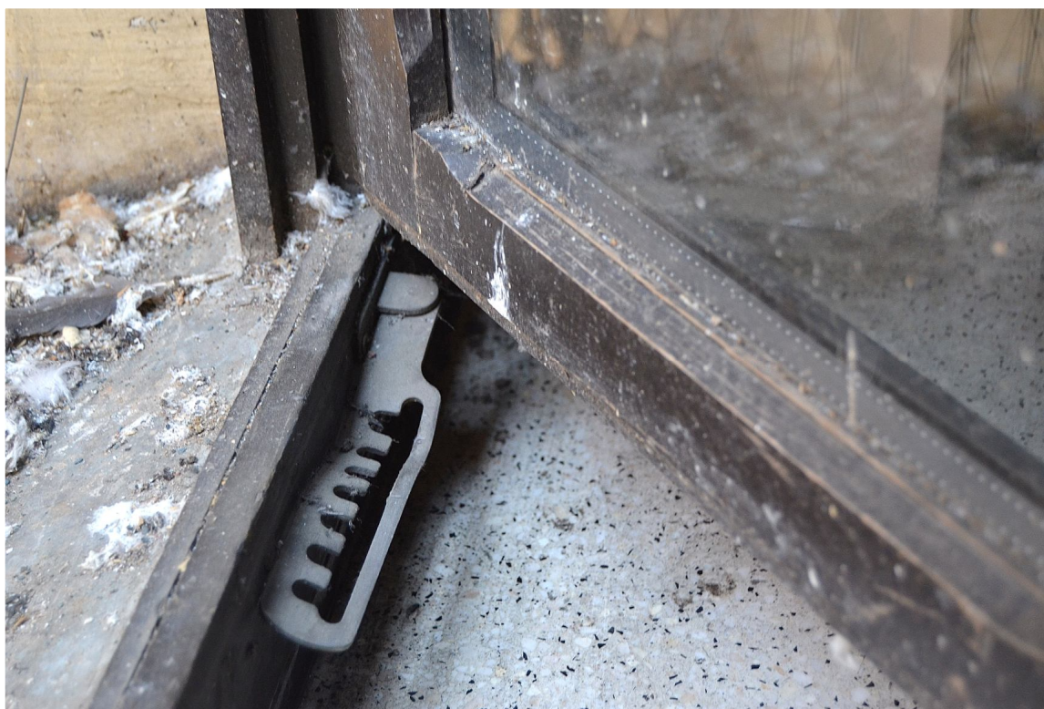
Il. 8 Poznań, ul. Masztalarska 8 – Klatka schodowa „A” (południowa) - widok na fragment progu, stojaka oraz skrzydła stolarki okiennej
