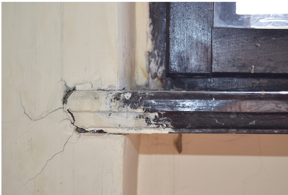
Il. 30 Poznań, ul. Masztalarska 8 – Klatka schodowa „D” (północna) - widok na fragment stolarki oraz nosek parapetu wewnętrznego
