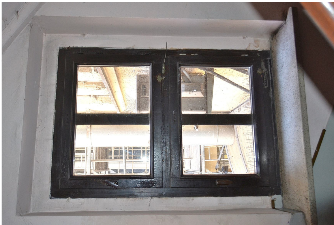
II. 3 Poznań, ul. Masztalarska 8 – Klatka schodowa „A” (południowa) - II kondygnacja klatki schodowej– okno nr 2
