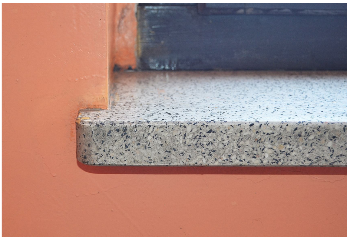
II. 16 Poznań, ul. Masztalarska 8 – Klatka schodowa „B” (południowo-zachodnia) - widok na fragment parapetu wewnętrznego stolarki okiennej
