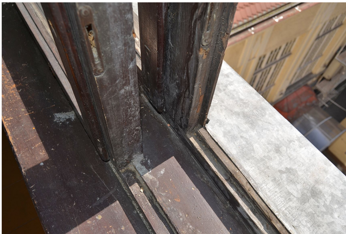
II. 31 Poznań, ul. Masztalarska 8 – Klatka schodowa „D” (północna) - widok na fragment stolarki okiennej (słupki i próg skrzynki)
