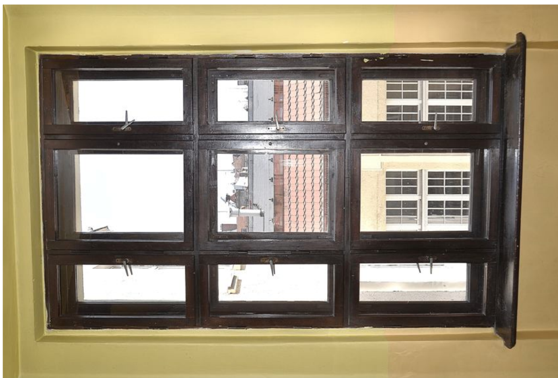
II. 20 Poznań, ul. Masztalarska 8 – Klatka schodowa „C” (północno-zachodnia) - III kondygnacja klatki schodowej – okno nr 3 (rewers)
