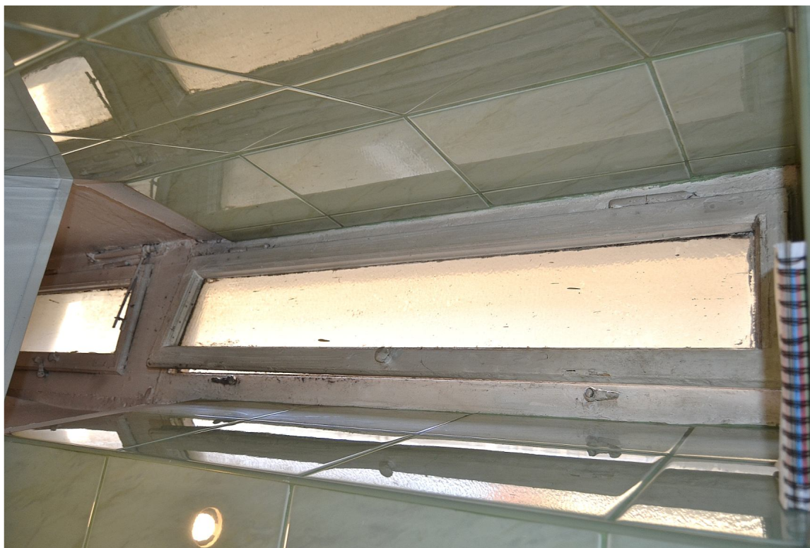
Il. 33 Poznań, ul. Masztalarska 8 – Sanitariaty przy klatce schodowej „C” (północno-zachodniej) - widok na fragment stolarki okiennej (słupki i próg skrzynki)
