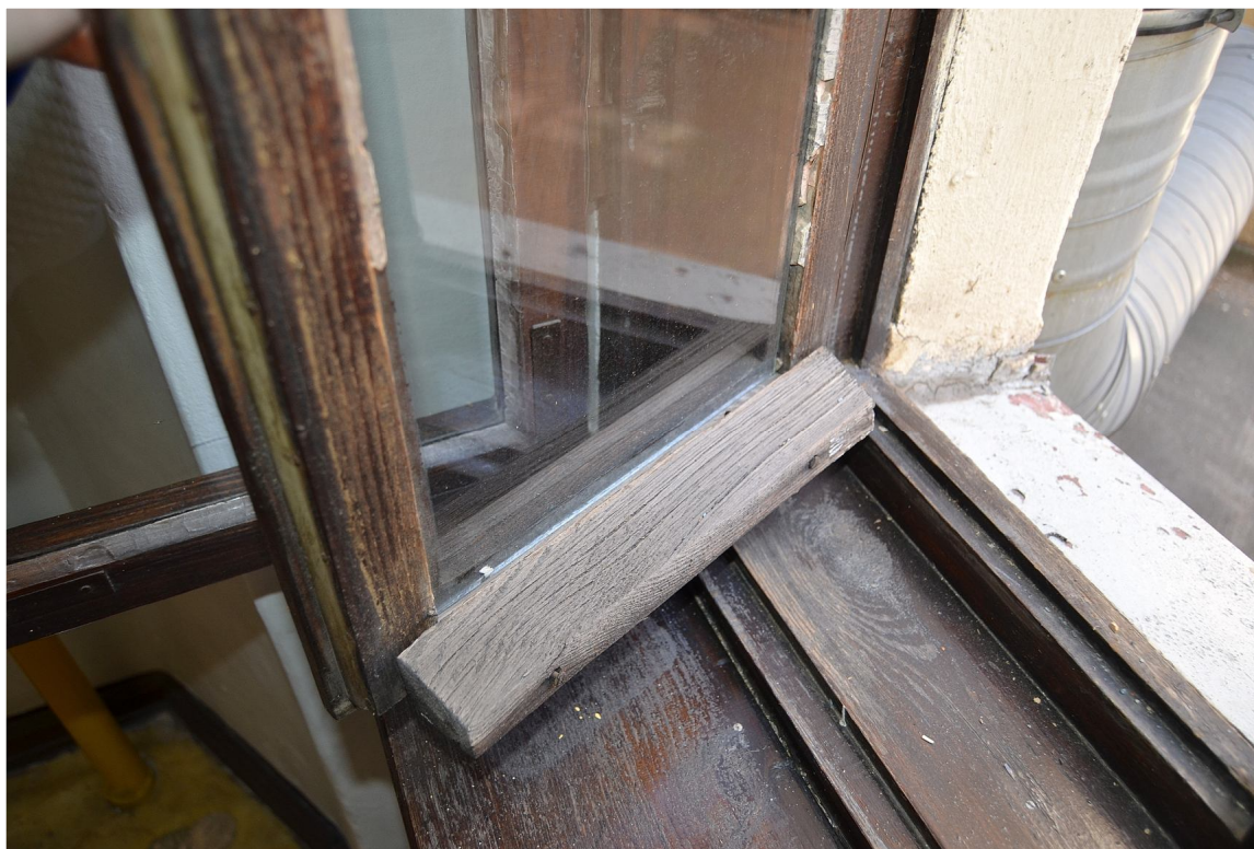
II. 23 Poznań, ul. Masztalarska 8 – Klatka schodowa „C” (północno-zachodnia) - widok na fragment stolarki okiennej (próg, stojak, skrzydła okienne)
