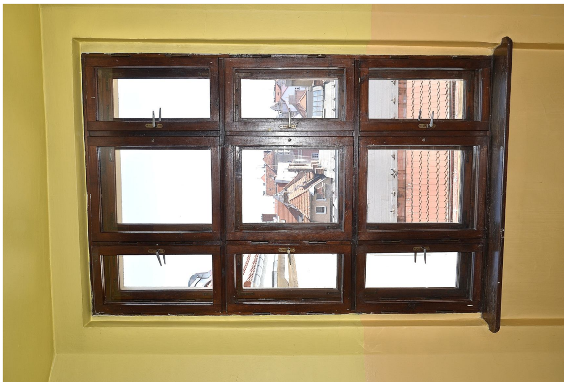
Il. 21 Poznań, ul. Masztalarska 8 – Klatka schodowa „C” (północno-zachodnia) - IV kondygnacja klatki schodowej – okno nr 4 (rewers)
