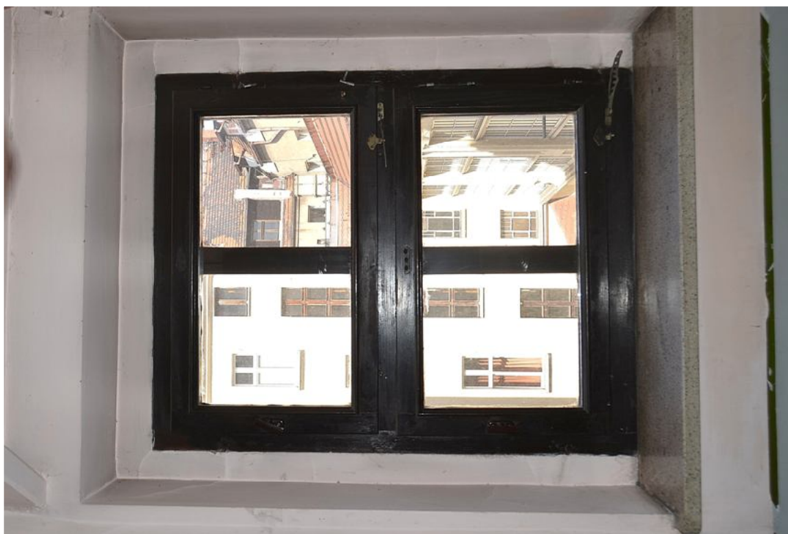
Il. 2 Poznań, ul. Masztalarska 8 – Klatka schodowa „A” (południowa) - I kondygnacja klatki schodowej – okno nr 1
