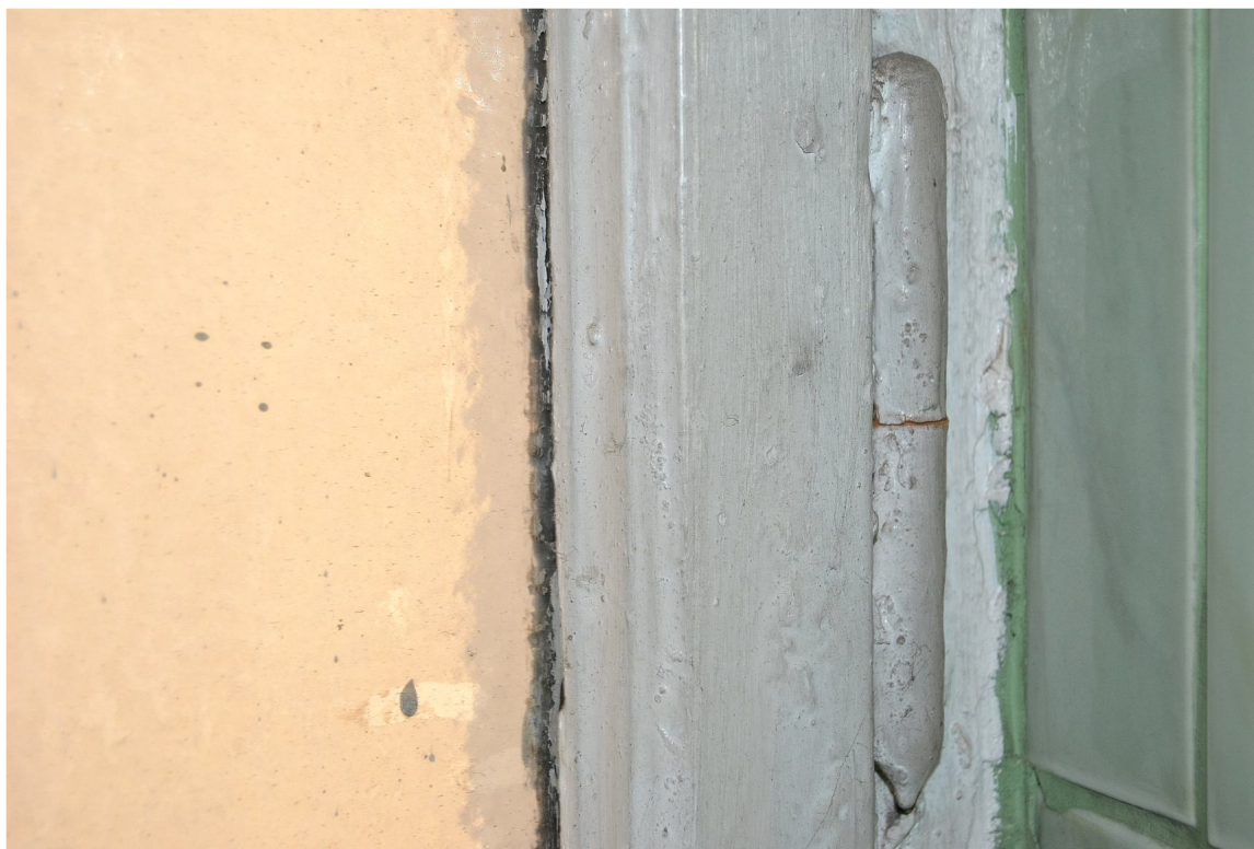
Il. 35 Poznań, ul. Masztalarska 8 – Sanitariaty przy klatce schodowej „C” (północno-zachodniej) - widok na fragment stolarki okiennej (słupki i próg skrzynki)
