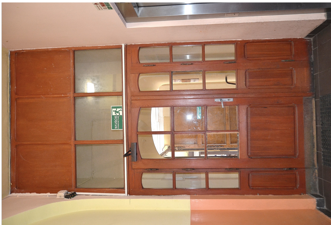
Il. 4 Poznań, ul. Maształarska 8A – drzwi wejściowe boczne z przejźdu bramnego TYP D/II
